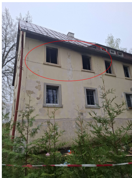
Osmolona elewacja zewnętrzna uszkodzone okna
