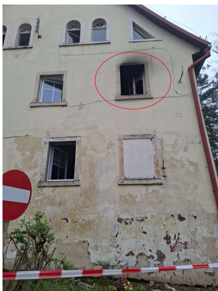
Osmolona elewacja zewnętrzna uszkodzone okna
