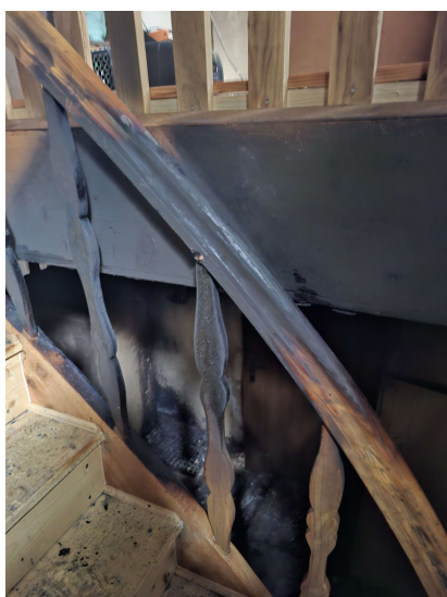
Osmolone elementy schodów, schody na strych do wymiany
