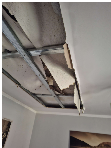
Uchodzenia na korytarzu i w zalanym mieszkaniu
