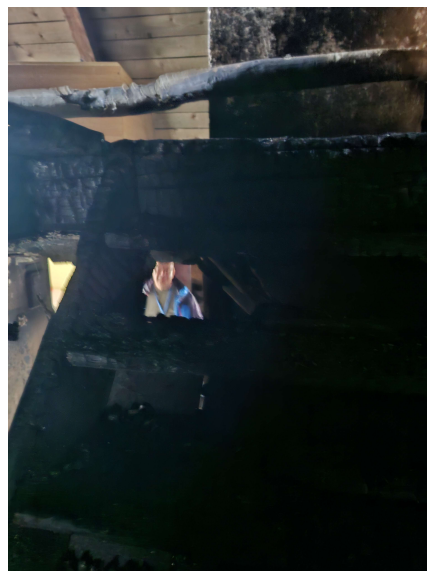
Osmolone elementy schodów, schody na strych do wymiany
