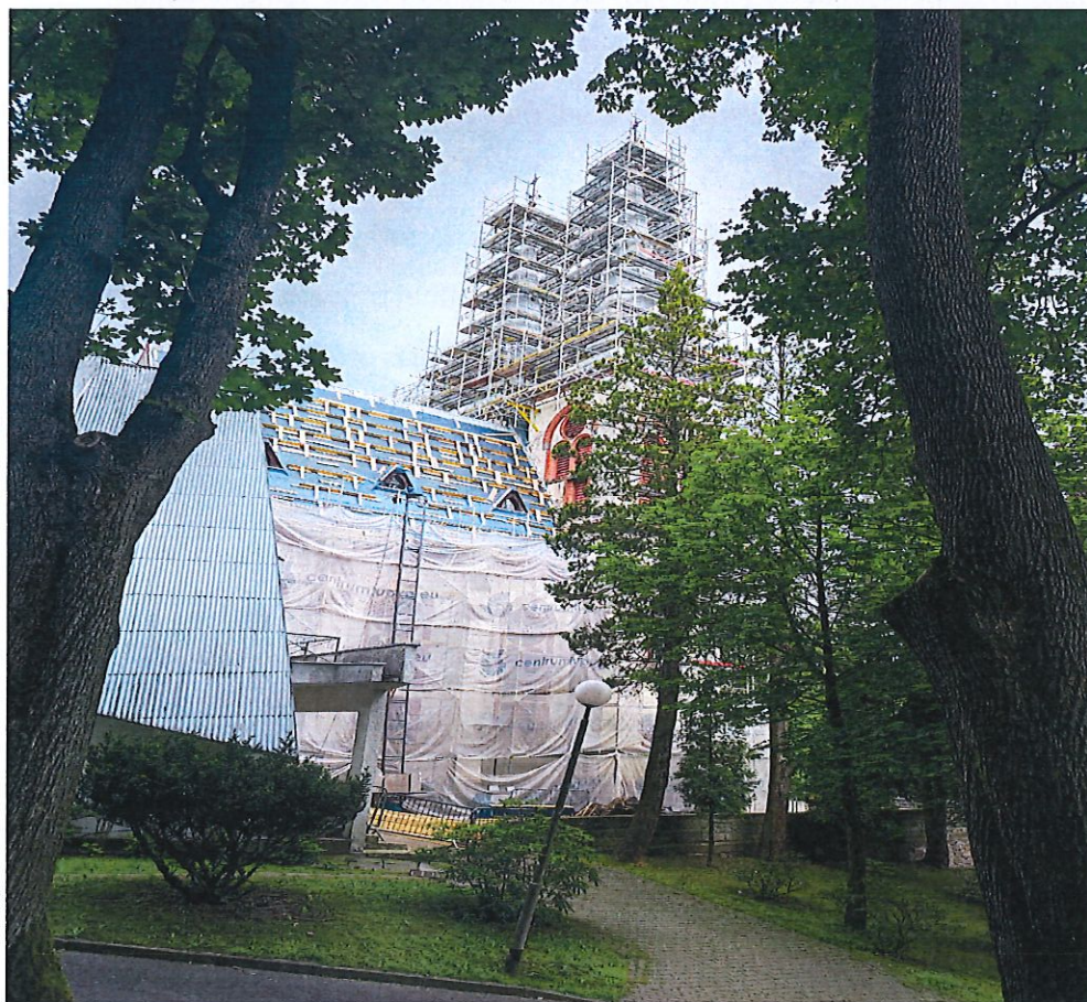
Fot. 2. Remont pokrycia dachu iglic dwóch wież w kościele pw. św. Jana Oblubieńca NMP.
