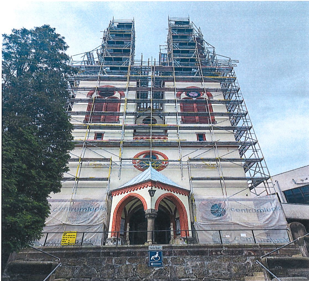
Fot. 3. Remont pokrycia dachu iglic dwóch wież w kościele pw. św. Jana Oblubieńca NMP.
