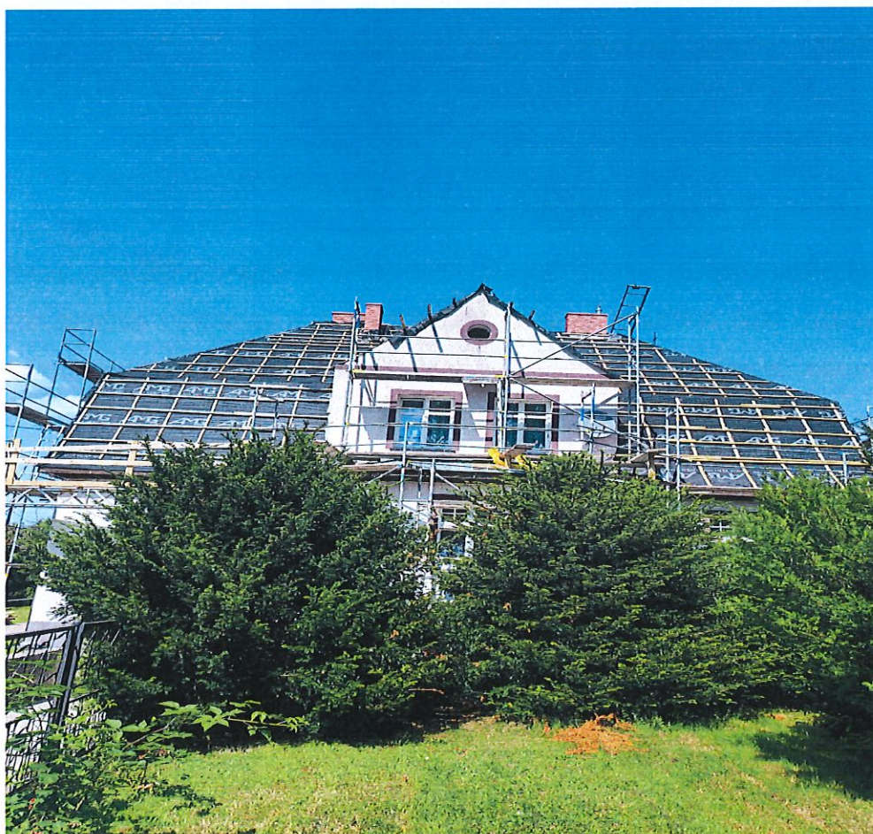
Fot. 4. Remont pokrycia dachowego z termomodernizacją budynku parafialnego przy kościele pw. Podwyższenia Krzyża Świętego.
