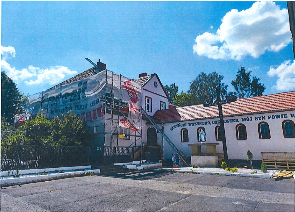
Fot. 1. Remont pokrycia dachowego z termomodernizacją budynku parafialnego przy kościele pw. św. Podwyższenia Krzyża Świętego.
