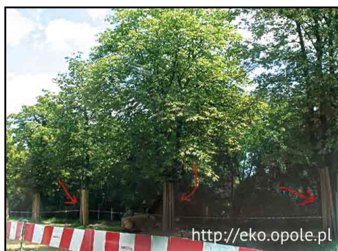
Rys. Przykład poprawnego zabezpieczenia drzew
